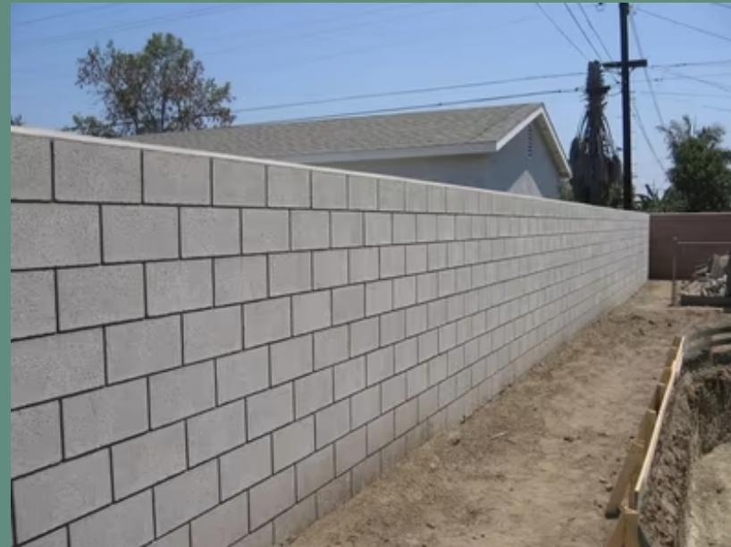
Muro de bloque de hormigon
