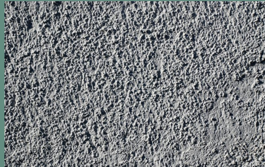
Hormigón en masa
